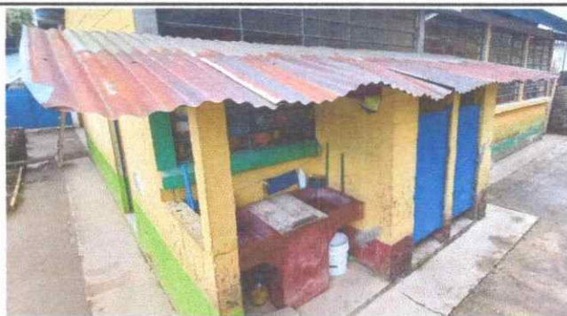
Foto 5: Se observa el modulo de baños con daños en su cubierta y estructura de lámina.
