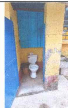
Foto 6: Se observa el modulo de baños con desgaste en sus muros y piso, así como los inodoros quebrados y en mal estado.
